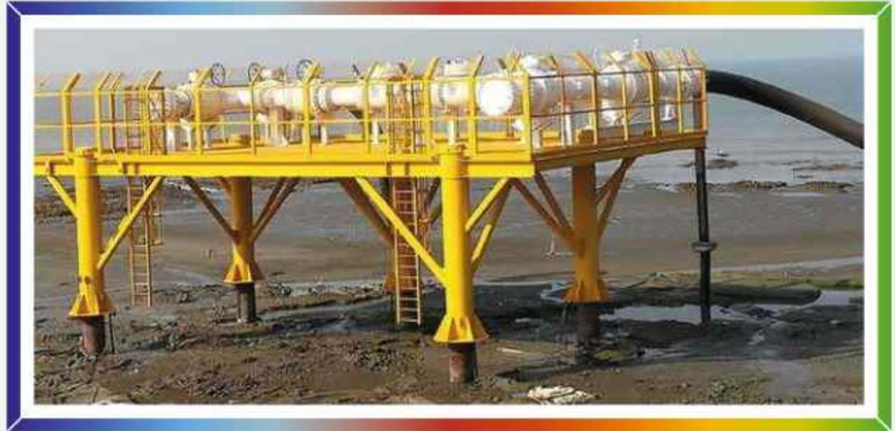
কক্সবাজারের মহেশখালী অর্থনৈতিক অঞ্চল-৩ এর বিলয় একাডে মৌজায় MLNG এক Summit LNG টার্মিনাল ০২ টির Sub-sea পাইপলাইনের অংশবিশেষ এক টাই-ইন গ্যেটে গুটকর্ম।
